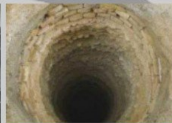
حفر چاه، به منظور بهره برداری زیرزمینی ماده معدنی
